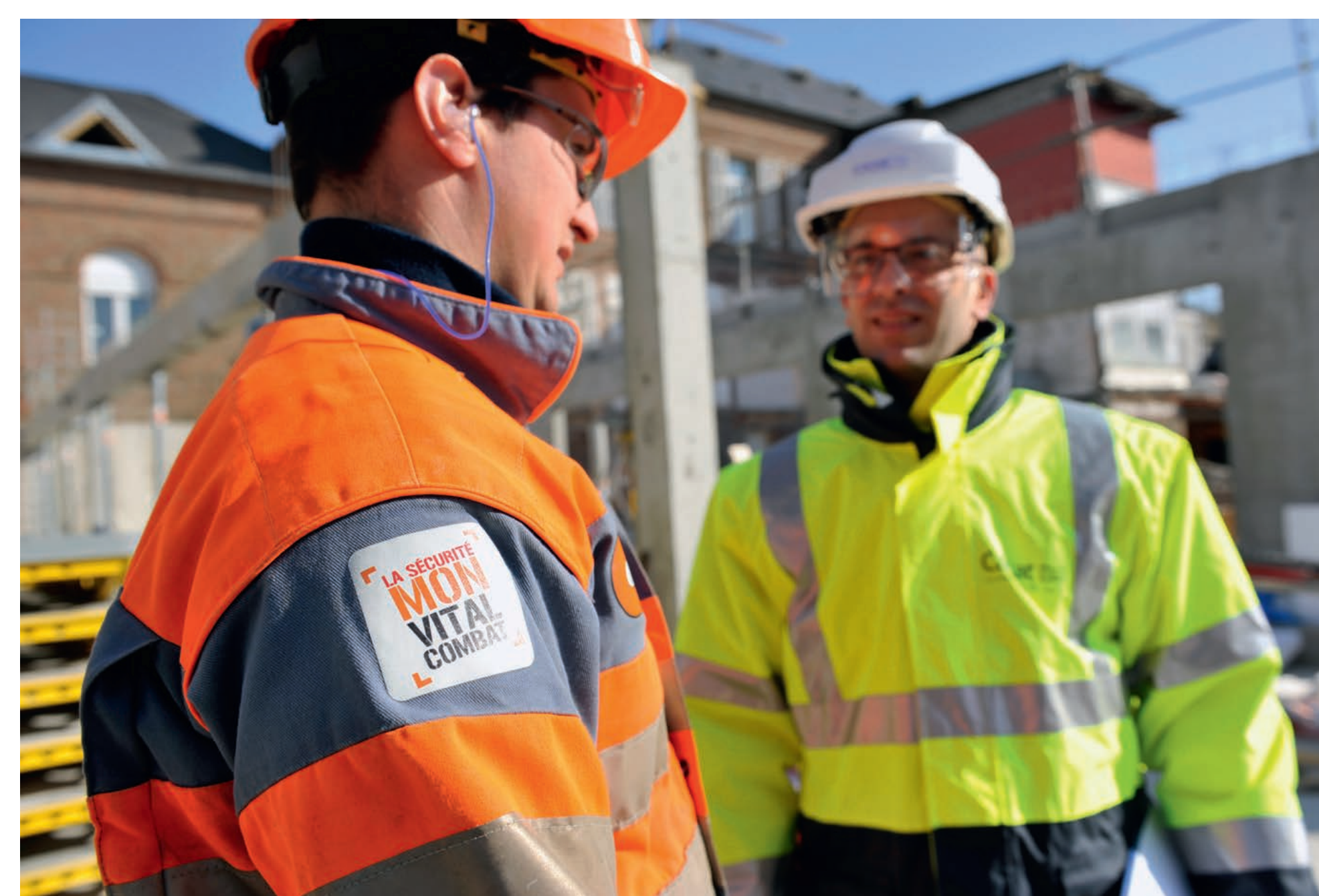
↑ Contrôle sur chantier par un agent de la Carsat © CONTEXTES
